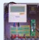
Płytkę sterującą, transformator mocy, listwa zaciskowa
