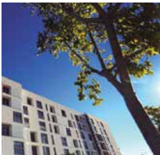
Nowy budynek mieszkalny (176 mieszkań) w Xàtiva, Hiszpania. ECO G
